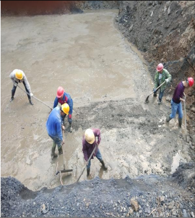
池底板基础施工
