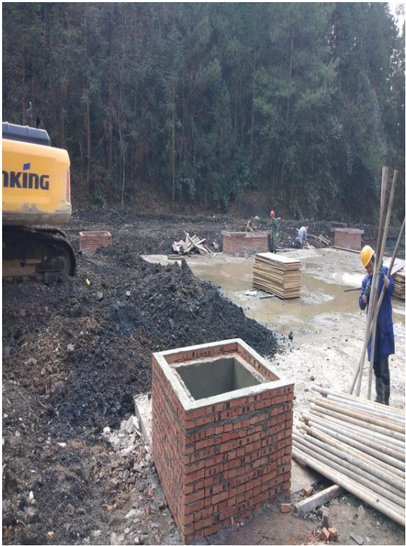
混凝沉淀池检查井砌筑
