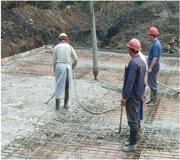
池体顶板施工
