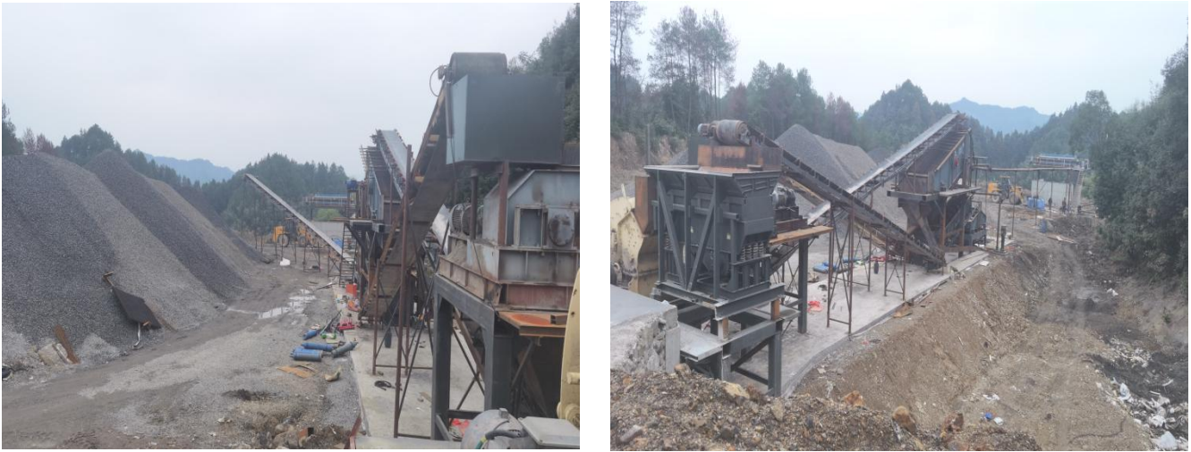
图 3-4 东坪镇建筑垃圾资源化利用处置厂现状图
