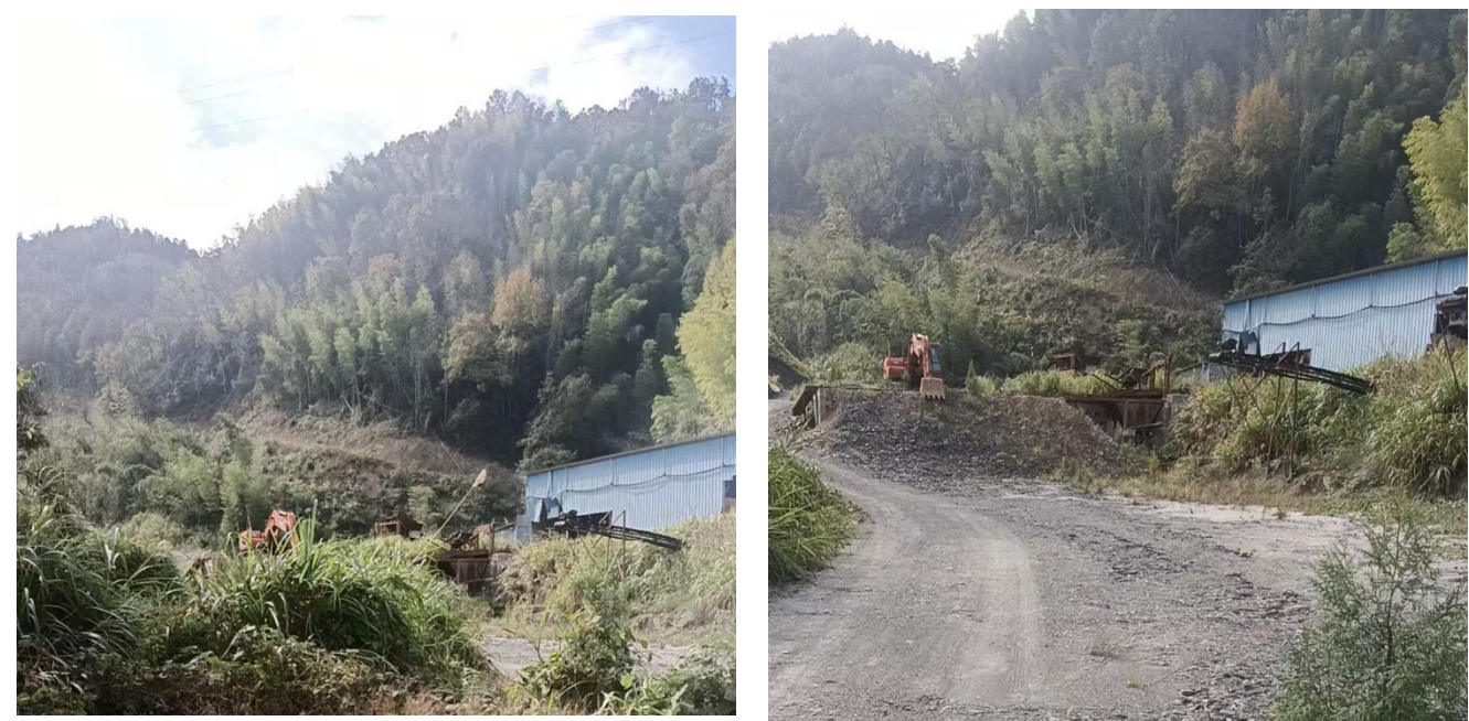
图 3-6 清塘铺镇建筑垃圾资源化利用处置厂现状图
