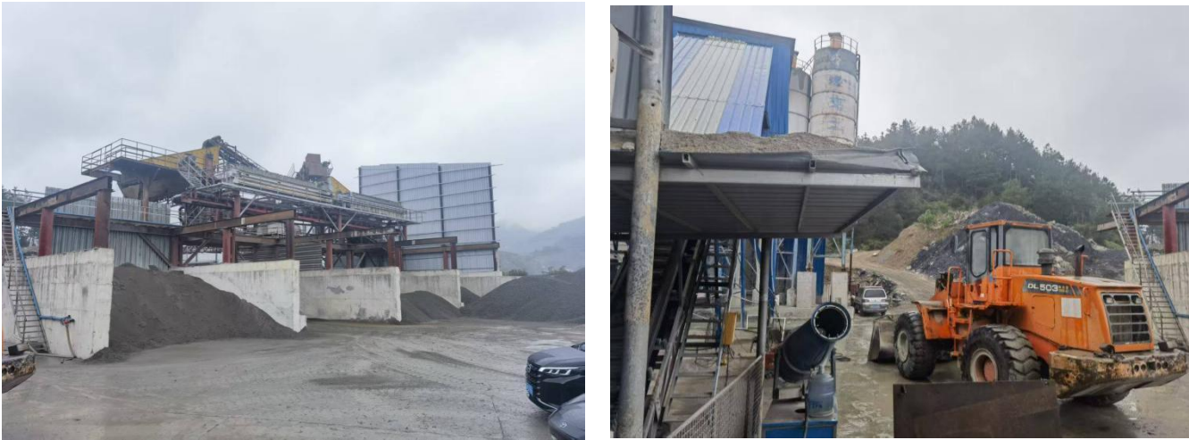
图 3-3 梅城镇建筑垃圾资源化利用处置厂现状图
