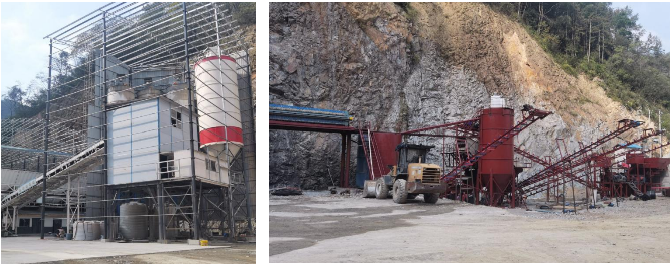
图 3-5 马路镇建筑垃圾资源化利用处置厂现状图
