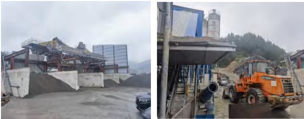
图 3-2 梅城镇建筑垃圾资源化利用处置厂现状图
