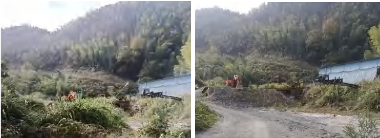
图 3-5 清塘铺镇建筑垃圾资源化利用处置厂现状图
