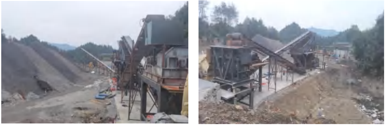
图 3-3 东坪镇建筑垃圾资源化利用处置厂现状图
