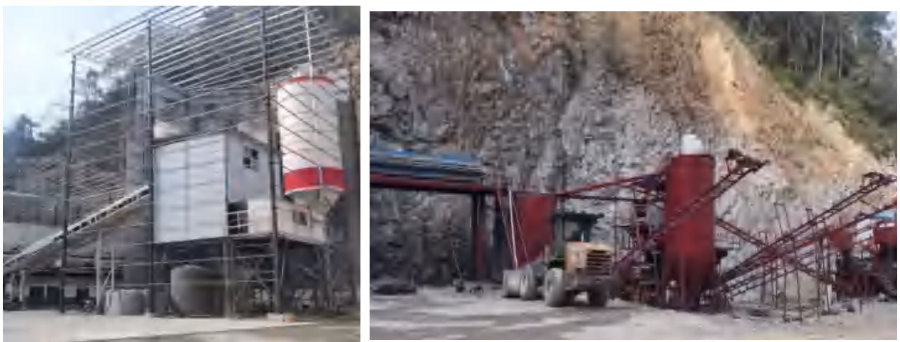
图 3-4 马路镇建筑垃圾资源化利用处置厂现状图
